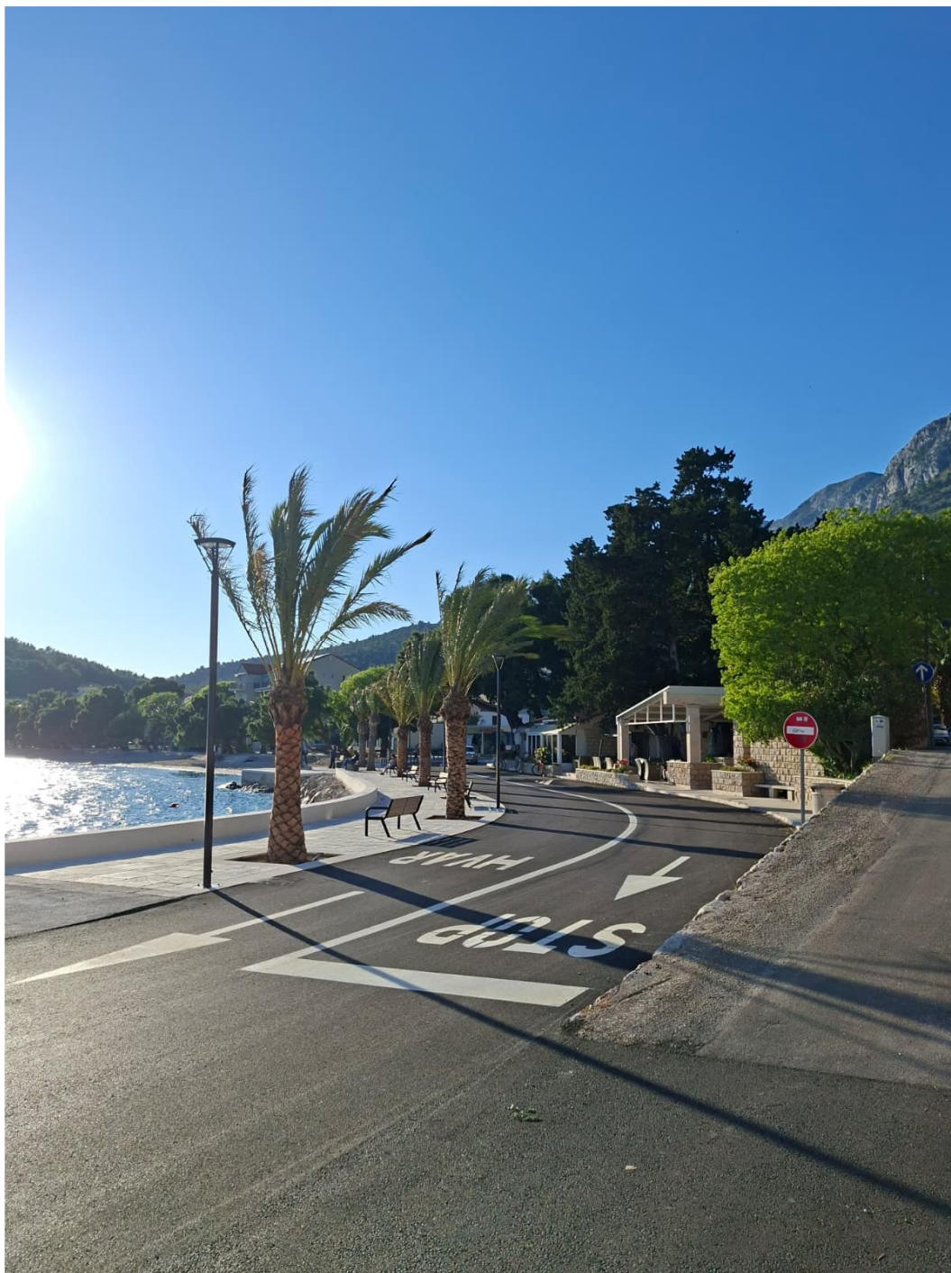
Slika 1.1 - 4 Postojeće stanje obale sjeverozapadno od postojećeg pristaništa Drvenik (Zeleni servis d. o. o., 04. 05. 2026.)
